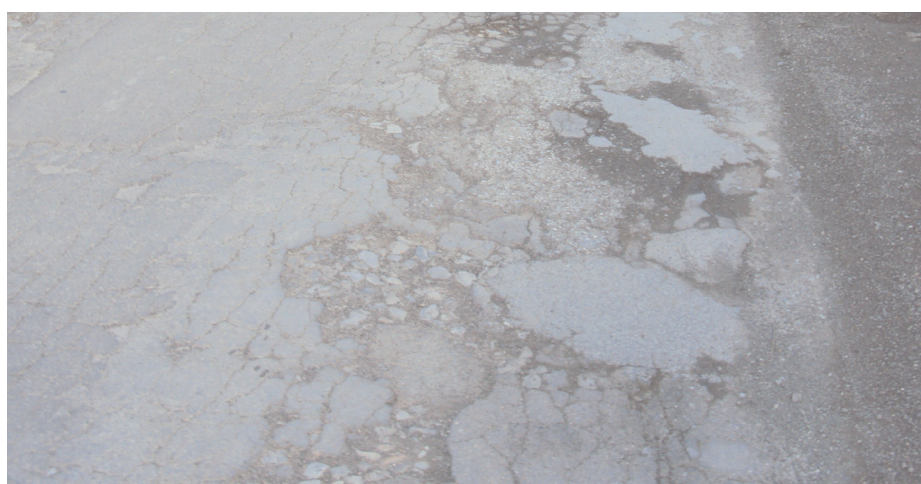
Interventi di ripavimentazione della carreggiata e regimazione idraulica acque superficiali
