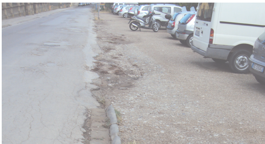
Intervento di ricostruzione del bordo stradale, marciapiede opere di regimazione idraulica
